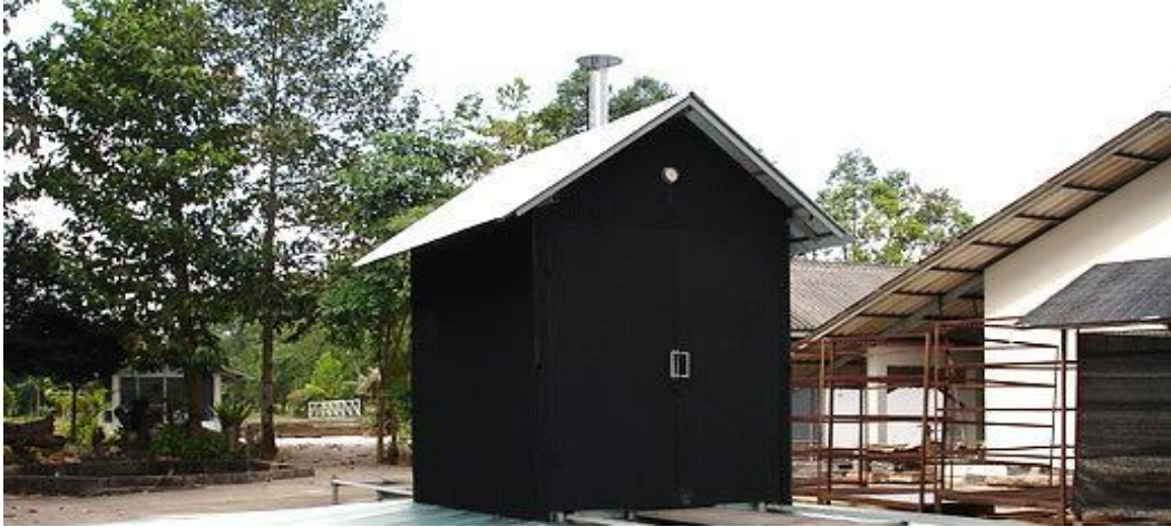
รูปที่ 7 ติดตั้งท่อระบายความชื้นบริเวณหลังคาเพื่อไล่ความชื้นจากยางแผ่น
