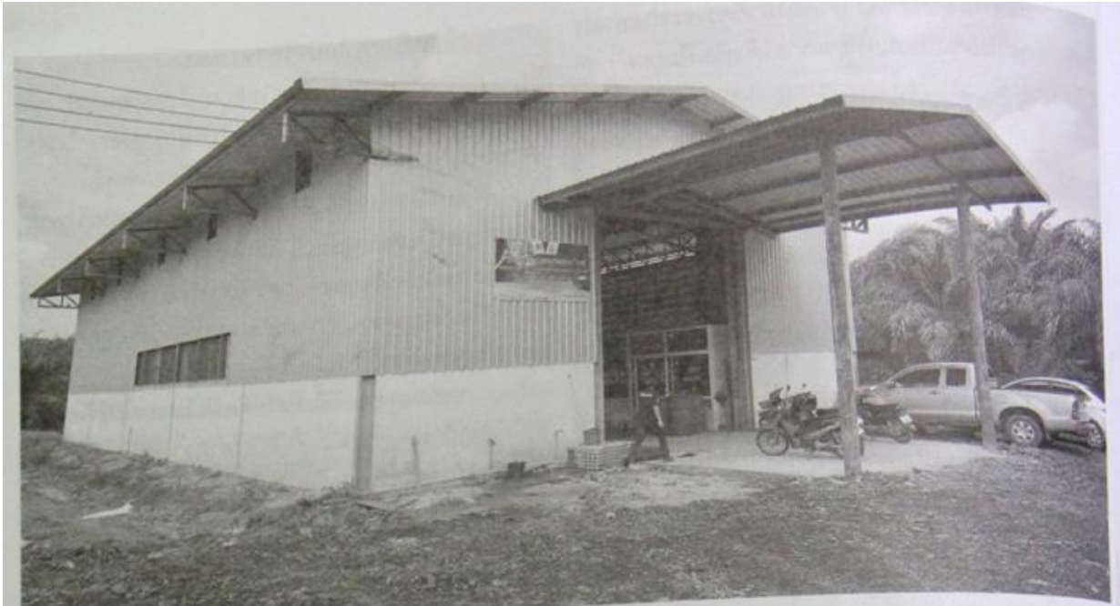
อาคารเดิมได้งบจากจังหวัดสตูล นำมาปรับปรุงเป็นโรงงานผลิตหมอนยางพารา
